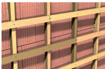
Крепление фасадных подконструкций
