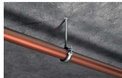
Монтаж одиночных труб
