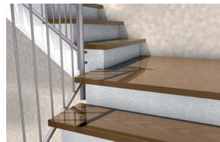
Лестничные ступени на бетонных лестничных балках
