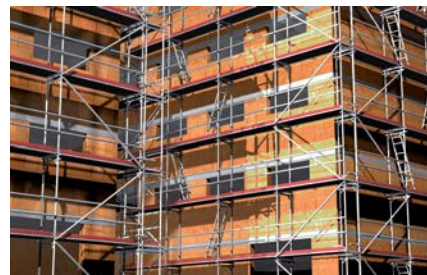
Фасадные строительные леса
